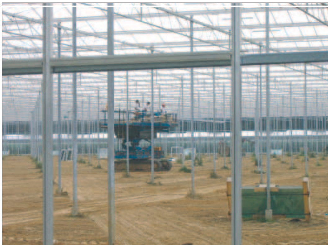
De Greenportkas Venlo, hier in aanbouw, telt 9.000 vierkante meter en maakt deel uit van een nieuw te bouwen semi-gesloten kas van 3,6 hectare. Tomatenteler Joep Raemakers gaat - samen met Universiteit Wageningen - in de afdeling van 9.000 vierkante meter het gewas volgen.
